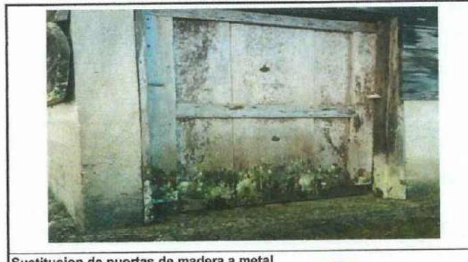
Sustitucion de puertas de madera a metal
