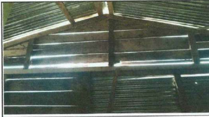
sustitucion de techo modulo I
